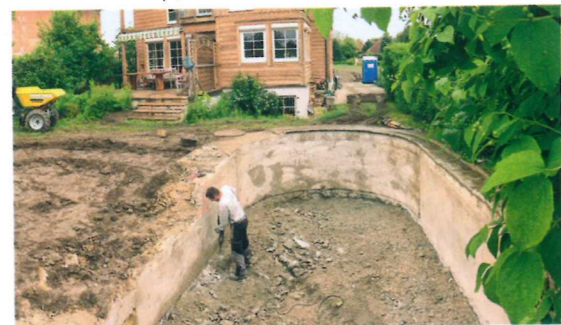
Der Umbau vom Stahlpool zum Schwimmteich dauerte fünf Wochen.
