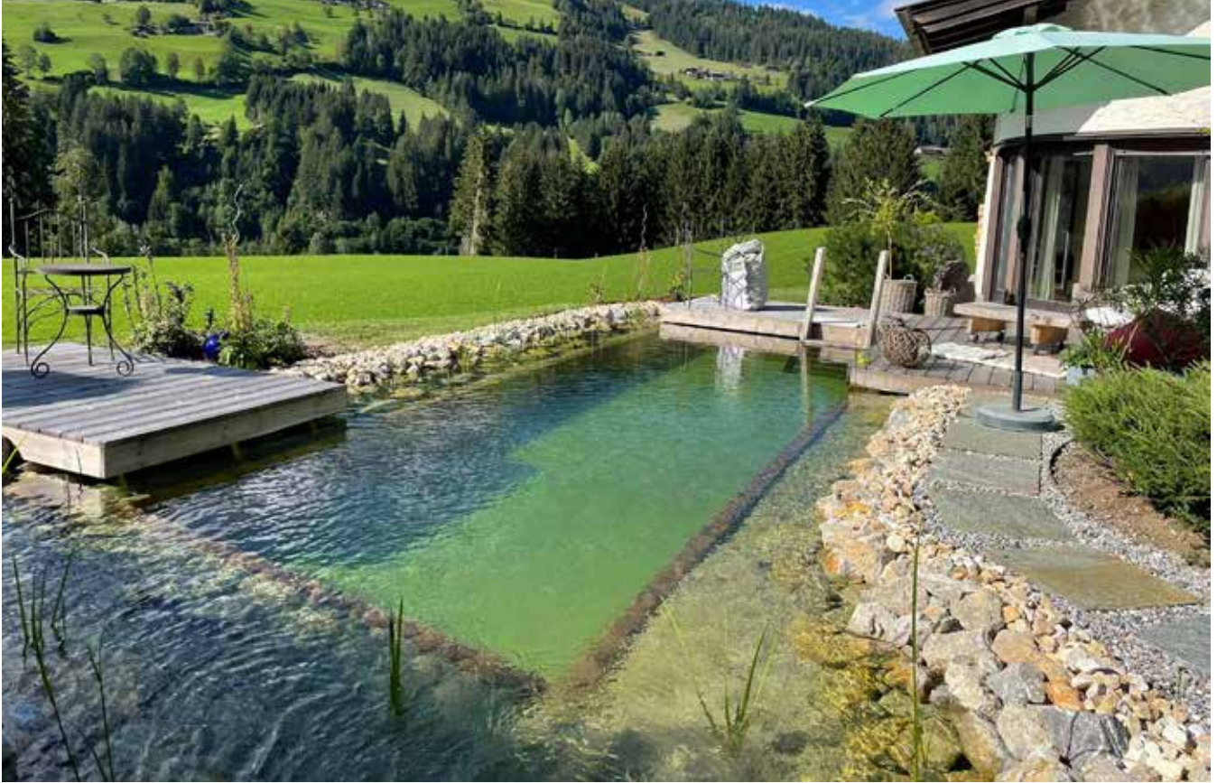
▲ Das aus Kalkbruchsteinen aufgebaute Ufer deutet einen Bergsee im Kleinen an. Der Schwimmbereich wird durch Palisaden begrenzt.
