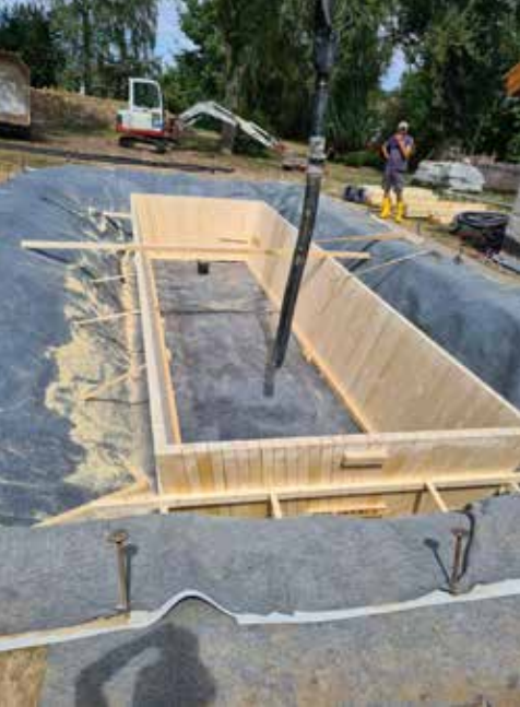
▲ Das Palisadenbecken ist aufgestellt, der Betonboden wurde mit großem gerät hineingepumpt und die Leitungen sind verlegt.
