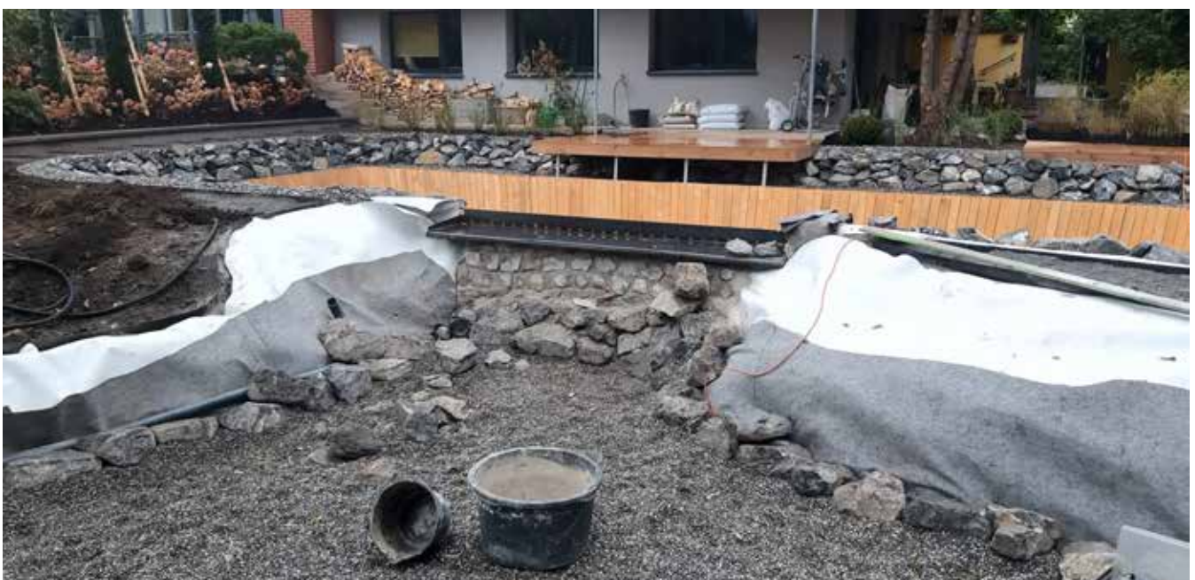
▲ Mauern und Böschungen wurden mit vielen Natursteinen aufgebaut und Bruchstein aus der Region bildet die Uferzonen.
