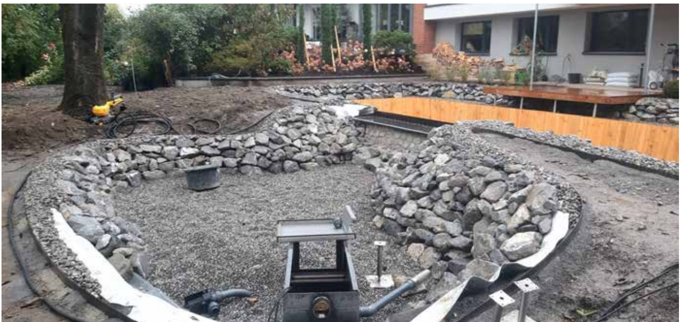
▲ Das Palisadenbecken ist aufgestellt, der Betonboden wurde mit großem gerät hineingepumpt und die Leitungen sind verlegt.
