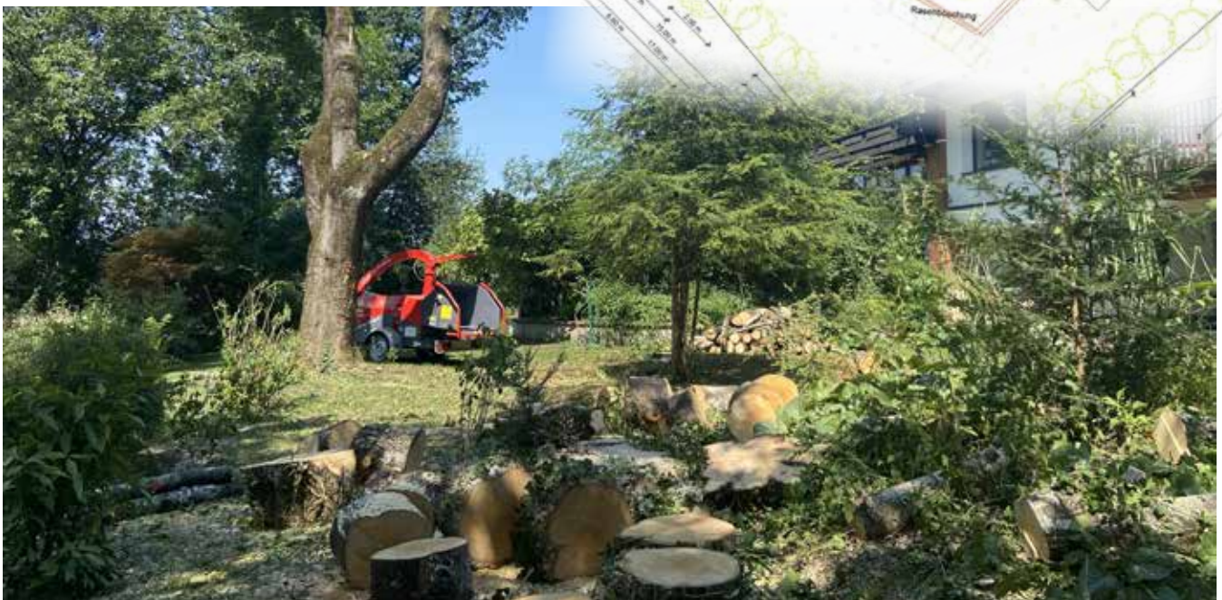
▲ Bevor es richtig losgehen kann, muss Platz geschaffen werden. Viele der Bäume und Sträucher, die im Wege standen, konnten umgesetzt werden, andere mussten gefällt werden.
