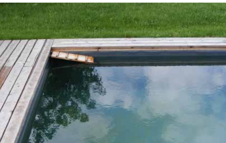
▲ Ein Tierausstieg aus Holz sollte in den Ecken des Naturpools angebracht werden. Denn hineingefallene Tiere schwimmen zumeist den Rand entlang, bis sie irgendwo anstoßen. Ist das Brett in der Ecke angebracht, werden sie dadurch hinausgeleitet.
