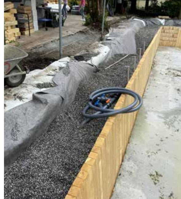
▲ Das Palisadenbecken ist aufgestellt, der Betonboden wurde mit großem gerät hineingepumpt und die Leitungen sind verlegt.
