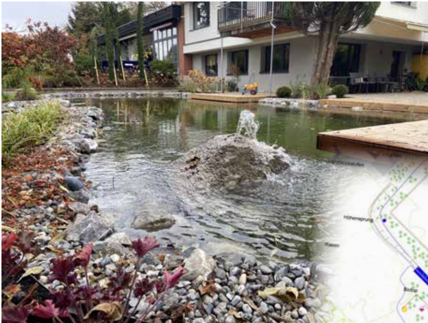
▲ Am Ende der umfangreichen Bauarbeiten breitete sich eine großzügige Wasserfläche im Garten aus.
