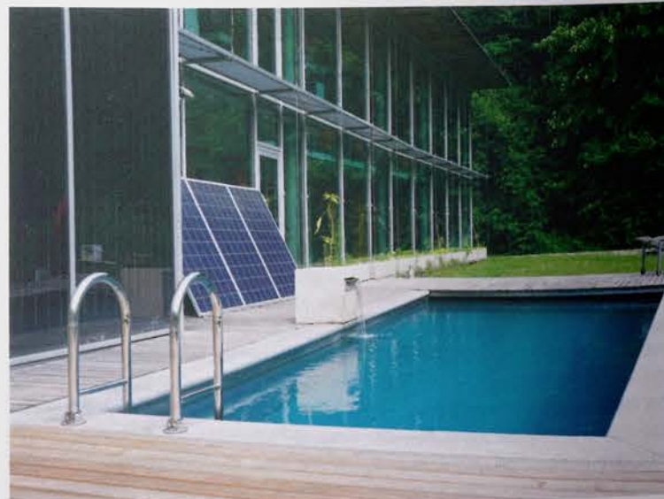
▲ Bestehende Living-Pools können nachgerüstet werden. Im Privatgarten wird das Solarmodul unscheinbar – gewöhnlich auf Dächern – installiert. Dazu kann eine solarthermische Anlage für die Poolerwärmung gesetzt werden.
