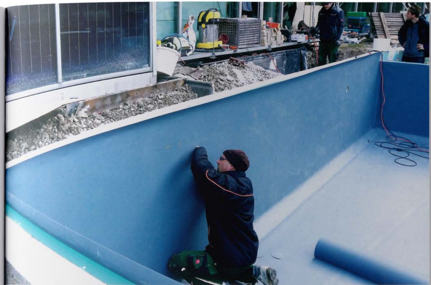
▲ Neben technischer Instandsetzung und Modernisierung bietet eine Sanierung auch immer die Möglichkeit, die Anlage an den veränderten Anspruch anzupassen. Die Farbe der Folie unterliegt beispielsweise modischer Entwicklung.
